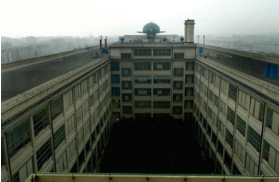
De voormalige Fiatfabriek in Turijn, met op het dak de testbaan voor auto's
