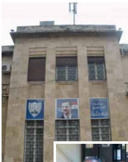
Het gebouw van de Orde in Aleppo
