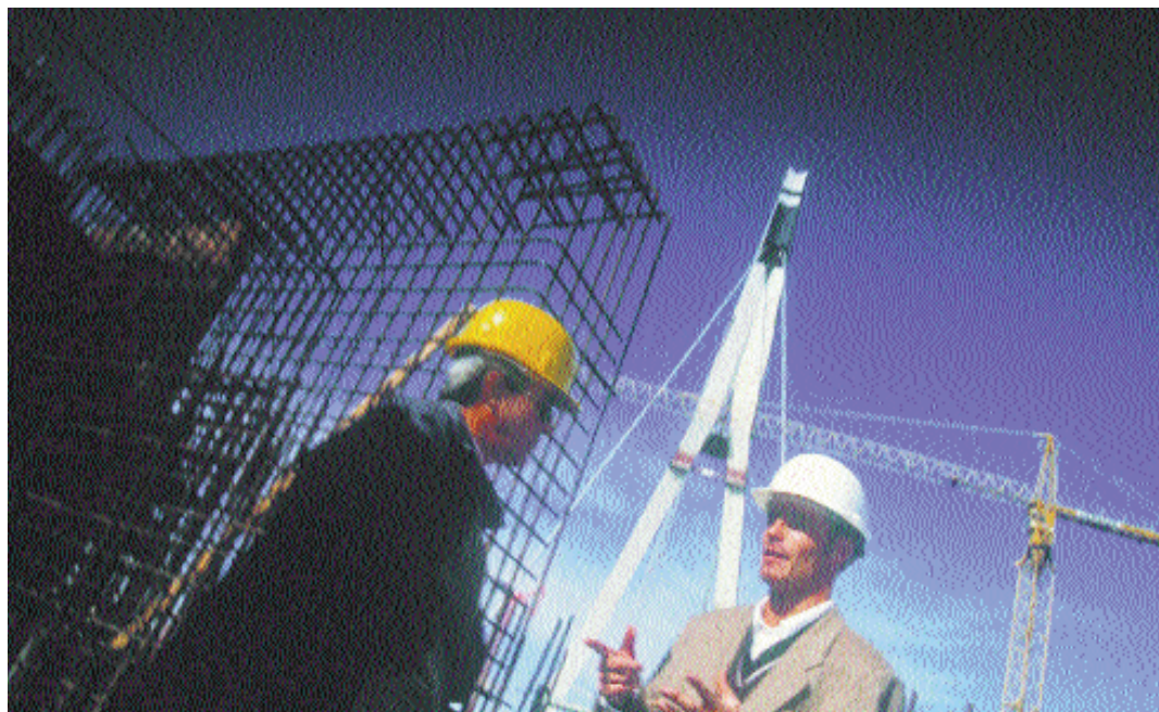
Rotterdam, oktober 1995: bouw van de Erasmusbrug
